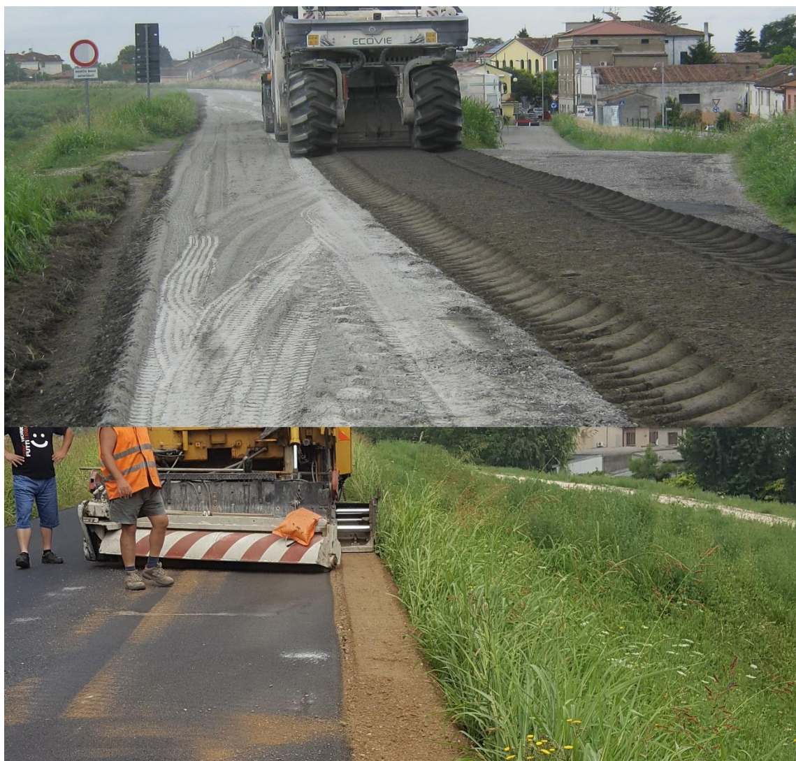
Figura 25. Fasi di realizzazione
