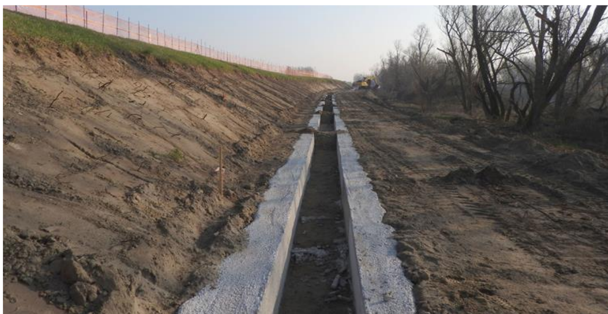
Figura 30. Esempio di diaframma realizzato
