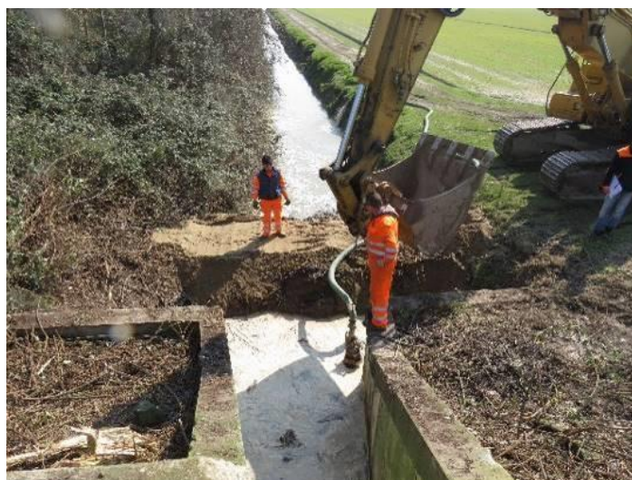
Figura 27. Fase di sostituzione di una chiavica
